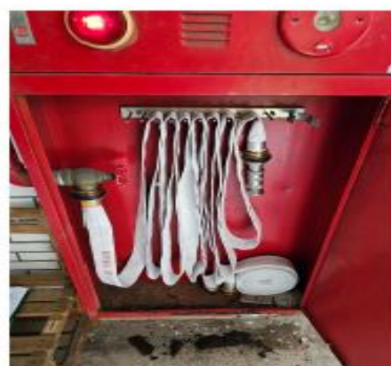
消防水帶更新後
