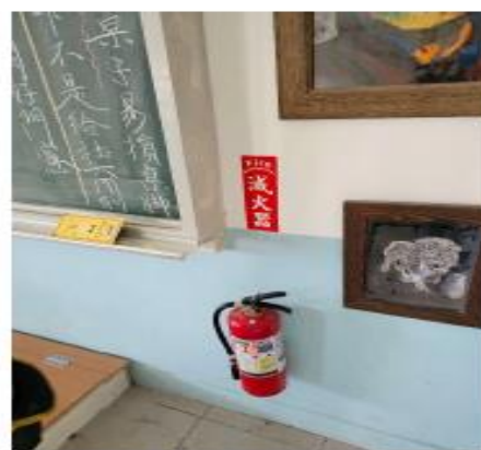
滅火器標示牌補充後
